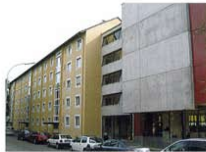
Anbindung an ein bestehendes Wohnhaus aus den 1950er Jahren
