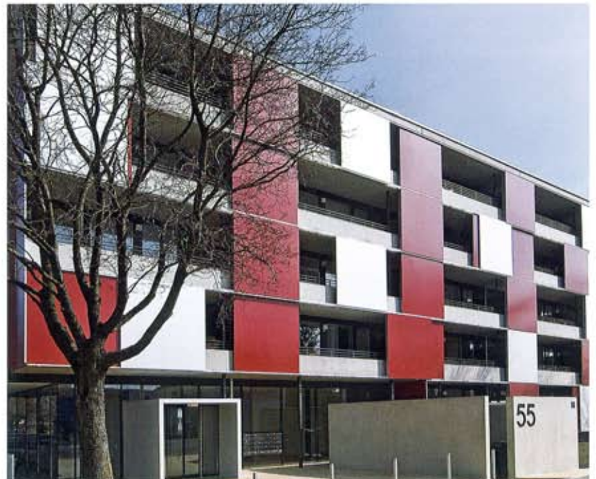
Das Erscheinungsbild zur Straße ist geprägt durch große Alu-Scheiben; Sicht- und Sonnenschutz bieten durch das Wechselspiel der Ladenstellungen von Wohnung zu Wohnung ein sehr lebendiges Bild
